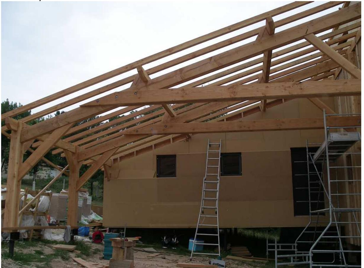
Depuis deux ou trois ans, on travaille sur des épaisseurs en toiture de 28 cm et 6 à 10 cm complémentaire en extérieur. En paroi, on a 12 cm en ouate de cellulose ou fibre de bois, et à 10 cm extérieur en fibre de bois. L'avantage de la fibre de bois en isolation extérieur est la résistance à la chaleur. Même si le coût de la construction est un peu plus élevé, ce système permet de pallier à l'inconvénient, s'il n'est pas bien pris en amont, de l'évacuation de la chaleur dans une maison en bois.
