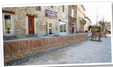
Rénovation du tour de ville à Martres Tolosane.
