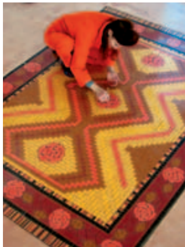
Tapis, pavement en mosaïque inséré dans une chape de béton teinté. P 37
