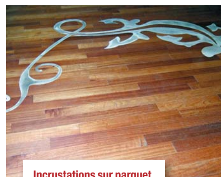
Incrustations sur parquet.
