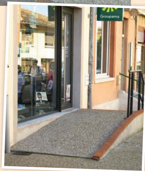
Exemple de travaux réalisés.
